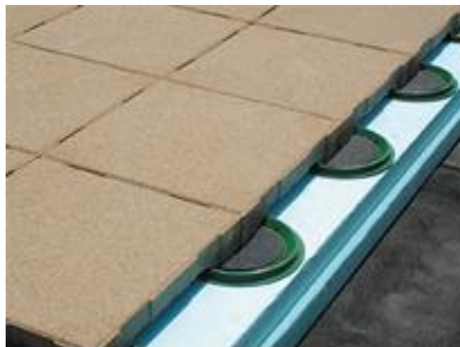
Figuur 12 : voorbeeld van Dreentegel®-systeem op omkeerdak
