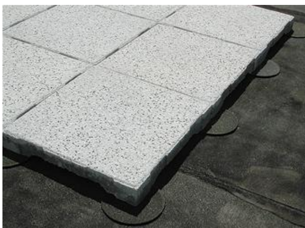
Figuur 13 : voorbeeld van Dreentegel®-systeem op bitumineus warmdak
